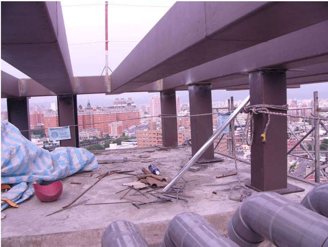
C 棟屋突 3 樓，距 1 樓地面約 50 公尺，型鋼高度約 1 公尺，有設置安全母索
